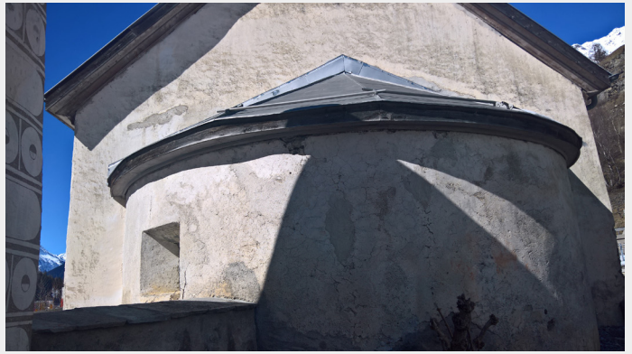
Reformierte Kirche Girsun – Aussenrestauration
